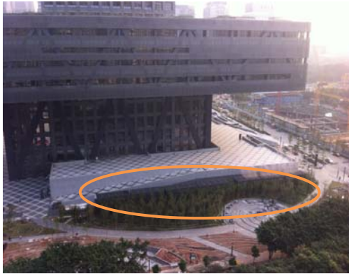
图 2-2 冷却塔地面进排风口
