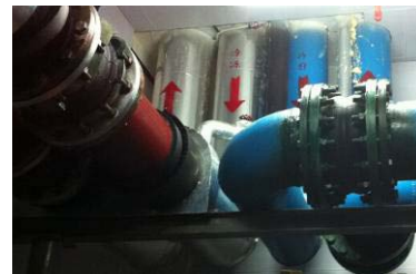
图 10 管道挠性管处理
