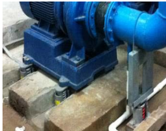
图 6 泵机及管道支撑隔振
