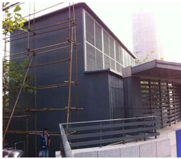
图 5 冷却塔隔声罩
